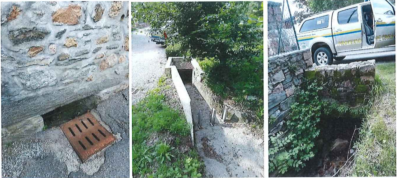
Foto – Reticolo Minore: Ingresso tratto tombinato di via Roma (sx), di via Bozzonaccio (centro) e di via della Croce (dx)
