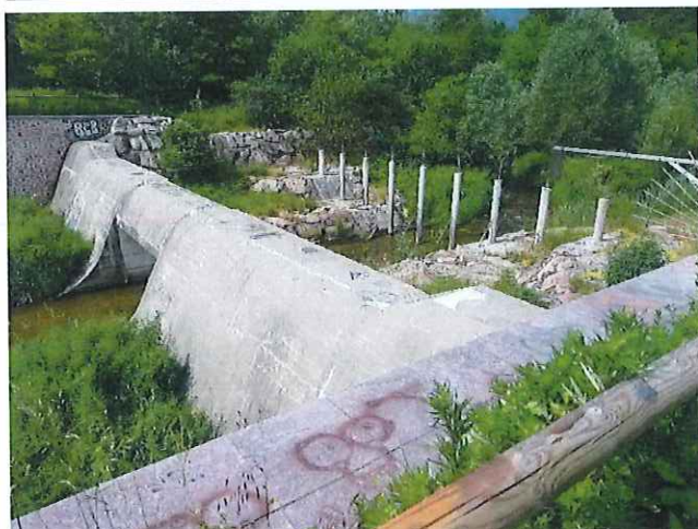
Torrente Bolletta – Opere idrauliche (diga e briglie) (sx) e vasca di laminazione (dx) atte a contenere le piene per i Comuni posti a valle (Porto Ceresio)
